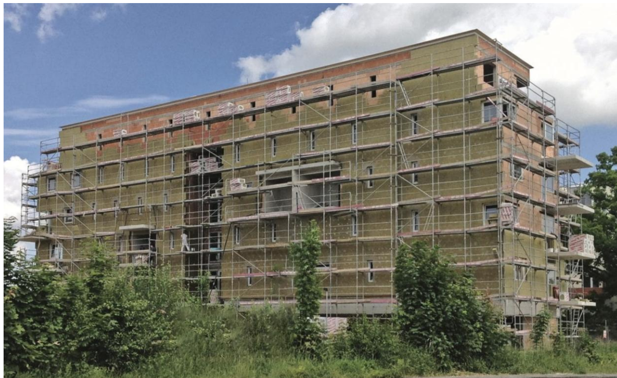
Obrázek 11 Ukázka zateplení fasády minerální vatou
