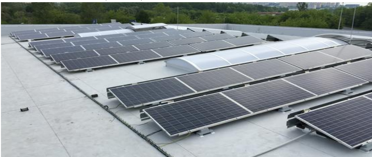
Obrázek 14 Instalace solárních panelů na ploché střeše
