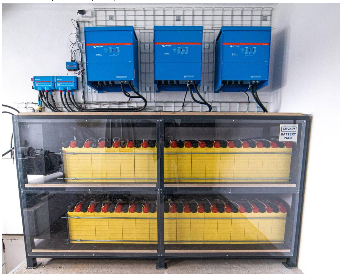
Obrázek 15 Sestava pro solární aplikace, střídače a bateriové úložiště 100kW
